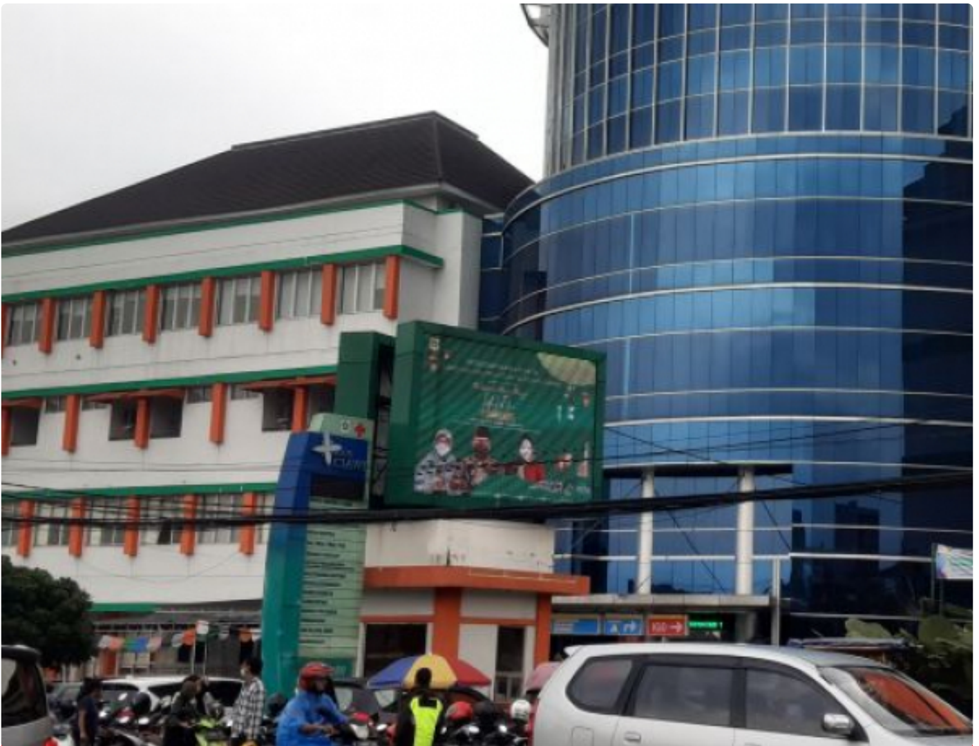
Photo depan Jalan RSUD Ciawi Kabupaten Bogor
